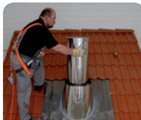
3. Rohrelement gemäß Standardversetzvorgang versetzen. Die Dachdurchführung gleichmäßig und waagrecht zur Rohrsäule ausrichten.
