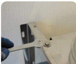
5. Grundplatte nun kraftschlüssig mit Konsolblech verschrauben. Weiterer Versetzvorgang siehe Putztüranschlüsse Seite 13.
