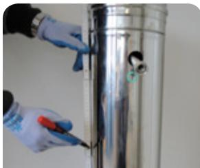
1. Fußteil auf die gewünschte Länge kürzen (Flex) und wieder in die Auflageplatte einsetzen.
