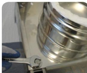
6. Grundplatte nun kraftschlüssig mit der Montageschiene verschrauben. Weiterer Versetzvorgang siehe Putztüranschlüsse Seite 13.
