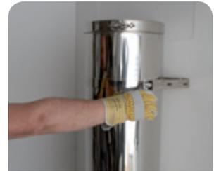
3. Rohrelemente versetzen und mit dem Wandhalter verbinden. Die Wandhalter- Laschen kraftschlüssig verschrauben.
