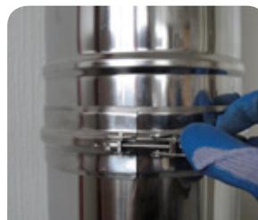
3. Rohrelement versetzen. Klemmband am Rohrelement über die Sicke der Stoßverbindung schließen und kraftschlüssig verschrauben.
