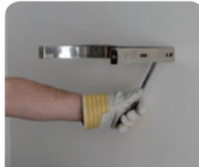
2. Bohrlöcher markieren und herstellen. Auf waagrechte Ausrichtung achten. Auf massive Wand montieren (nachstehenden Hinweis beachten).
