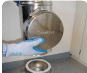
1. Putztüranschluss auf die Grundplatte bzw. den Fußteil versetzen.
