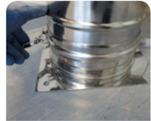
3. Klemmband über die Sicke schließen und kraftschlüssig verschrauben. Das Klemmband des Putztüranschlusses bleibt übrig!
