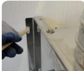
3. Bohrlöcher markieren und herstellen. Auf waagrechte Ausrichtung achten und gemäß nachstehendem Hinweis auf die **mas-sive** Wand montieren.
