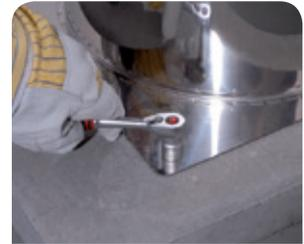
2. Grundplatte am bauseitig erstellten Fundament befestigen. Weiterer Versetzvorgang siehe Putztüranschlüsse Seite 13.
