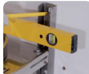
4. Bohrlöcher markieren und herstellen. Auf waagrechte Ausrichtung achten und gemäß nachstehendem Hinweis auf die **mas-sive Wand** montieren.
