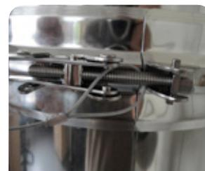
3. Sicherungsseil der Regenhaube am Verschluss des Klemmbandes befestigen.
