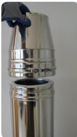
1. Mündungsabschluss versetzen und mit Klemmband kraftschlüssig verschrauben.
