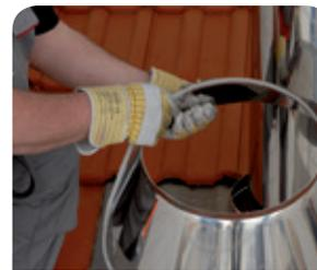
4. **Regenkragen-Montage:** Abdichtung mittels beiliegendem Dichtband an der Innenseite des Regenkragens anbringen (siehe beiliegende Einbauanleitung)
