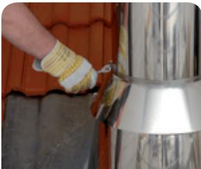
5. Regenkragen oberhalb der Dachdurchführung am Rohrelement versetzen und kraftschlüssig verschrauben. Weiter bis zum letzten Rohrelement. **ACHTUNG:** max. Höhen über Dach beachten (siehe Planungshinweise).
