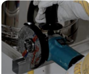
7. Der überstehende Teil der Montageschiene kann bündig abgeschnitten werden.
